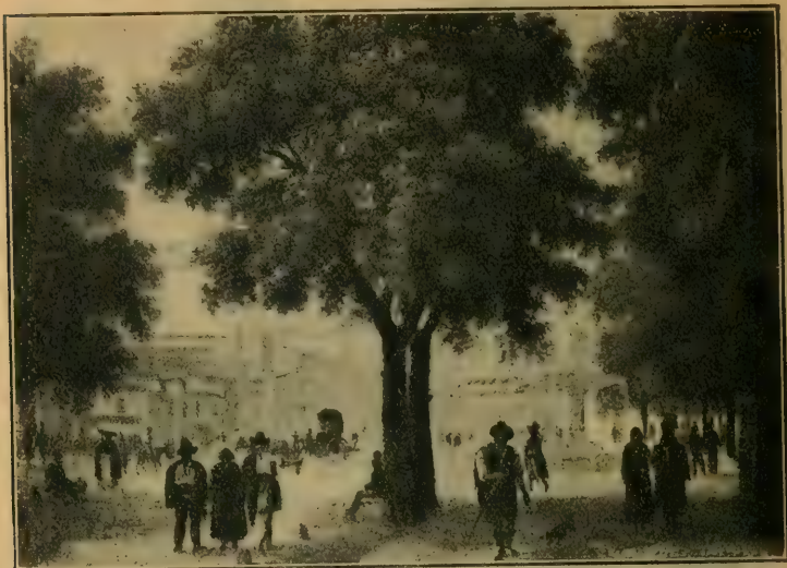
Subida a la calle de Atocha frente a la fuente de la Alcachofa.
